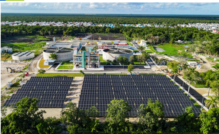
Instalación solar en PTAR Norponiente
