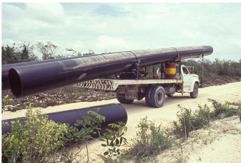
Construcción del acueducto de 32 pulgadas para Cancún El primer proyecto de asociación público-privada para la provisión de agua en bloque en México
