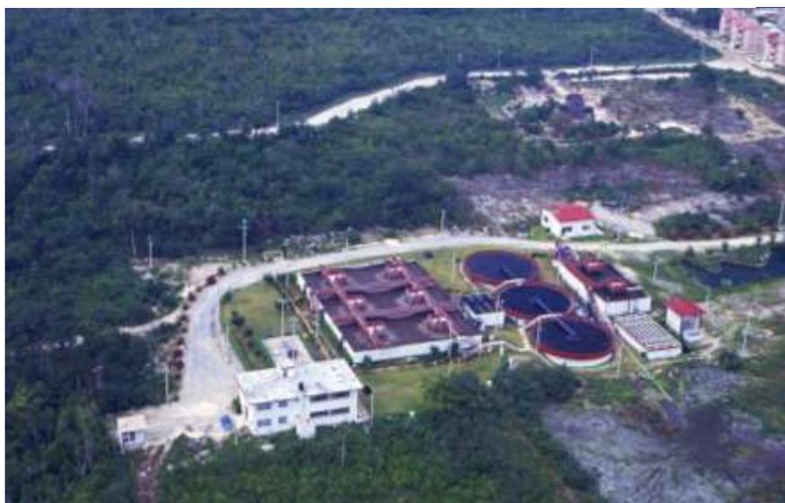
A la par del crecimiento, DHC Aguakan implementó tecnología en sus trenes de tratamiento de agua y lodos, con remoción de nutrientes y digestión anaeróbica de lodos, lo que produce agua de mejor calidad, reduciendo el impacto energético y ambiental.
