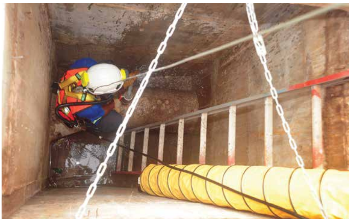
Trabajos en espacios confinados
