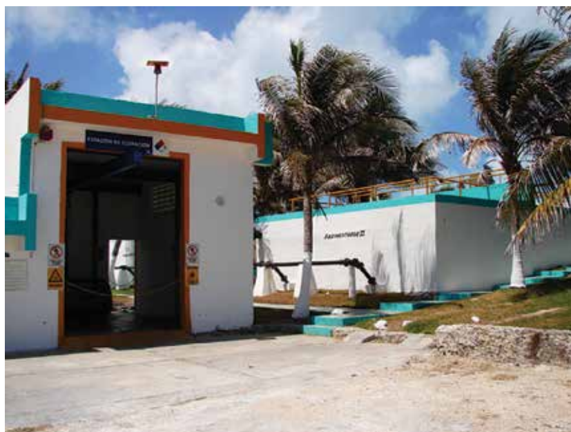
Planta de Tratamiento de Aguas Residuales Isla Mujeres
