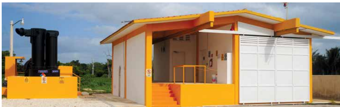
Caseta de cloración cerrada con equipo neutralizador de gas cloro Scrubber
