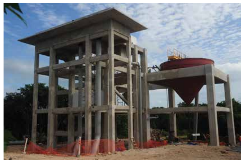
Construcción Segunda Etapa Planta de Tratamiento de Aguas Residuales Norte
